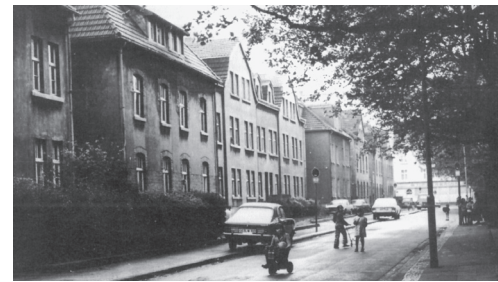
Blick in die Hüttenstraße im Jahre 1988.
